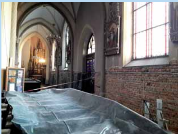
2. LUTY 2021 usuwanie tynków odsalających w nawie południowej
