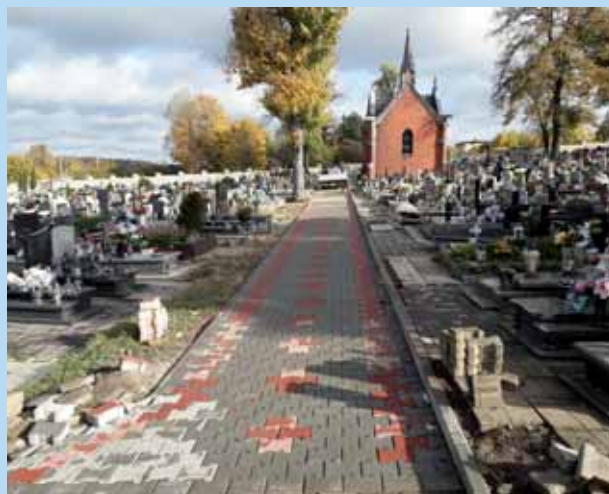
10. PAŹDZIERNIK 2021 gruntowny remont alei przy kaplicy cmentarnej
