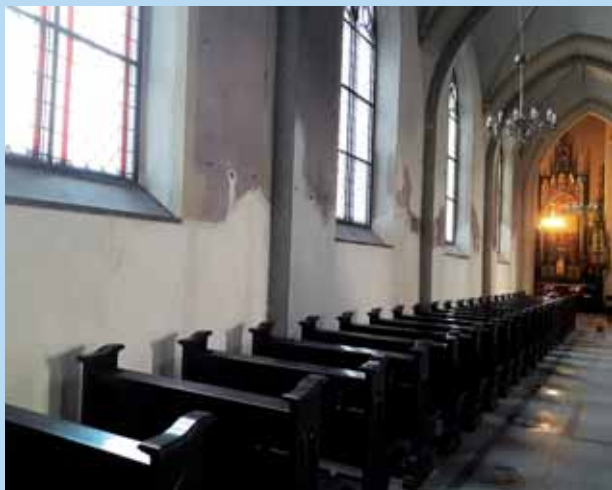
1. STYCZEŃ 2021 ostateczne tynki w nawie północnej
