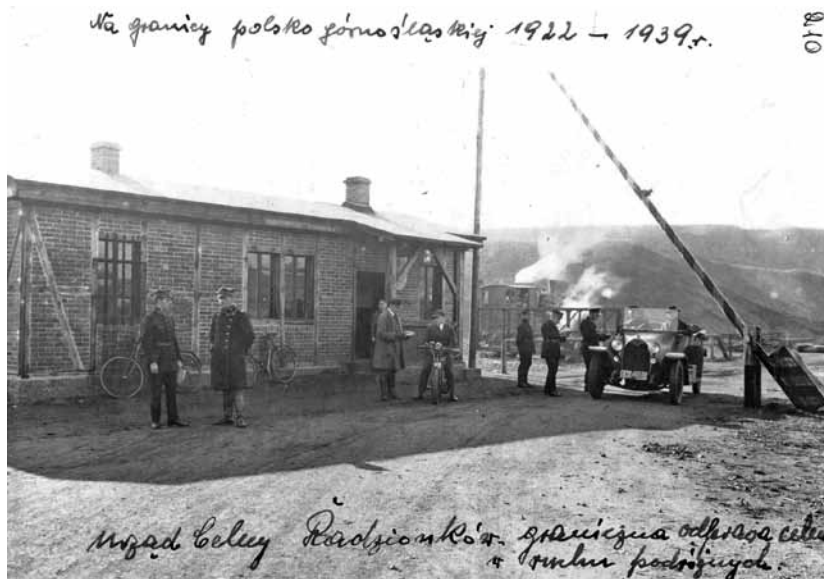
Przejście graniczne w rejonie skrzyżowania obecnych ulic Nałkowskiej i Hajdy.
