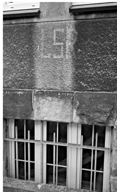
Napis LSR widoczny na elewacji budynku szkolnego przy ulicy Knosady
