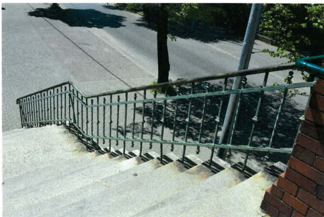
Wtórne schody z balustradą od strony południowej.
