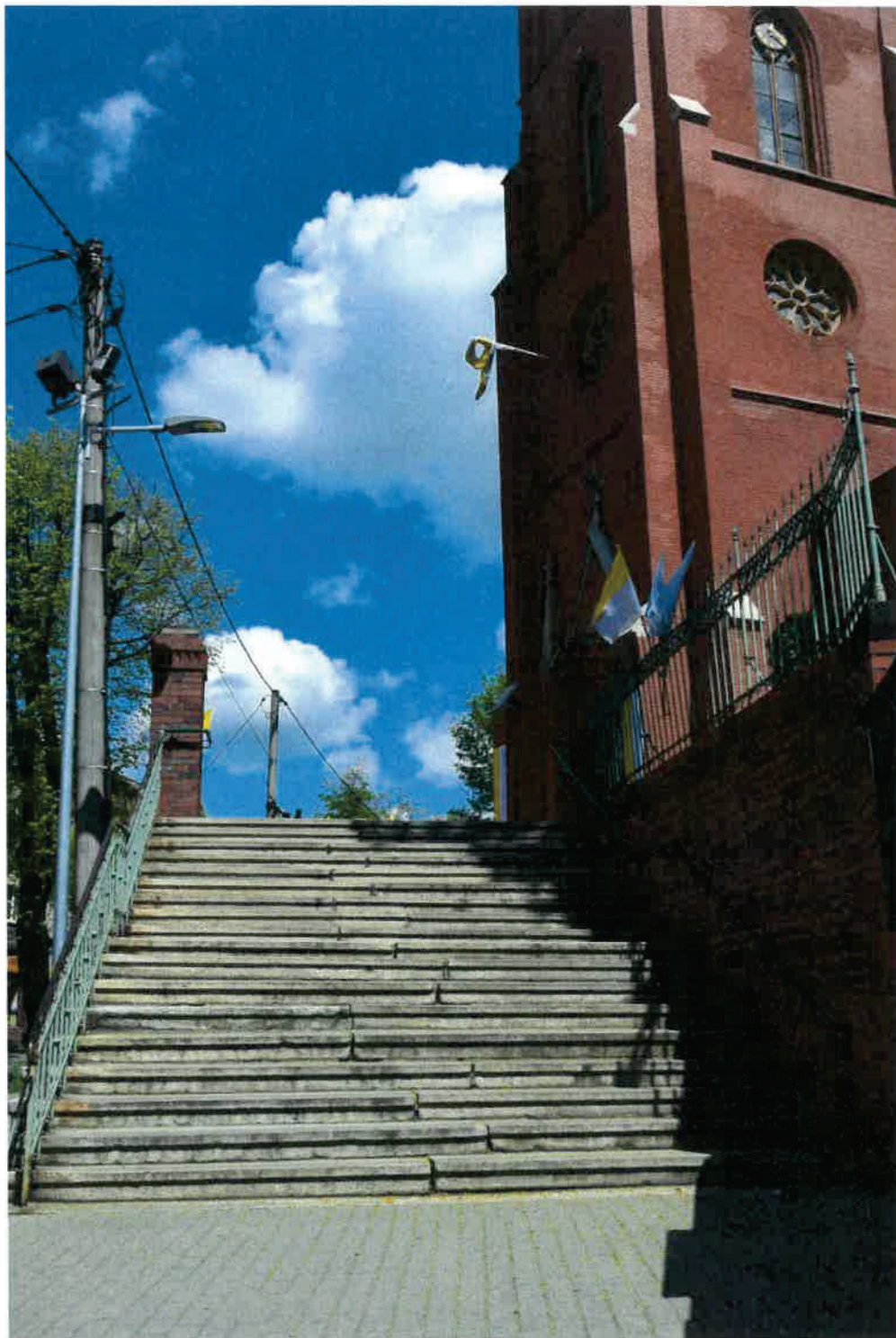
Widok przebudowanych w latach 50-tych schodów zewnętrznych od strony południowej.
